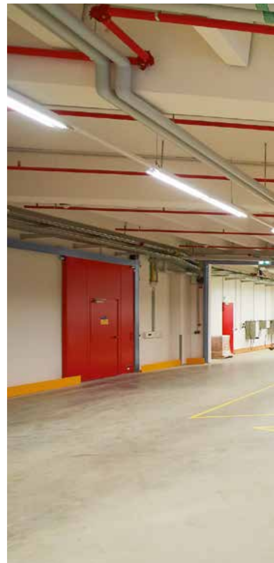
UNTEN RECHTS. Feuerschutz-Schiebetor FST 30-1 OD, 1-flügelig, Schlupftür, Feuerrot RAL 3000
